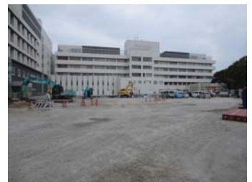
H30.1 南館跡地 左は新館 奥は本館
