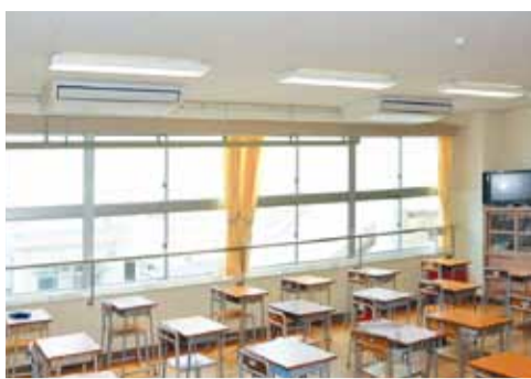
市内中学校の普通教室に順次エアコンを設置します
