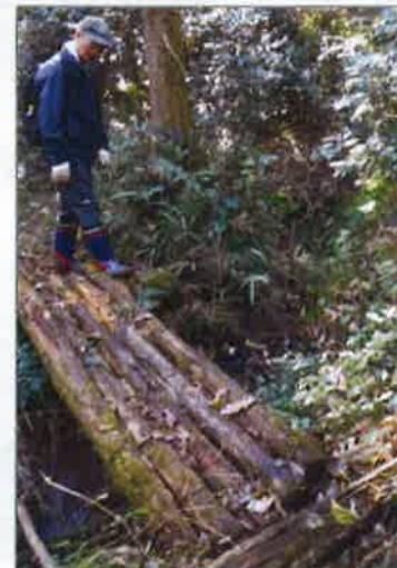
丸太橋補修作業の様子
