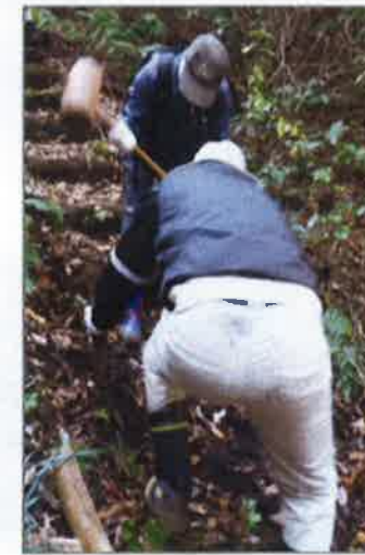
大磯堺の階段補修の様子
