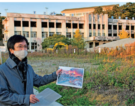
校舎の外壁の中で、モルタルがはがれて色が変わっている部分が見える。壮絶な火の強さを物語っています
