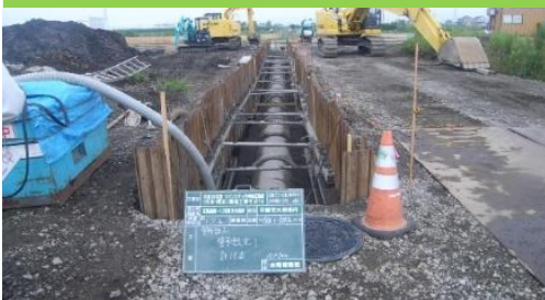
【新規整備】 ツインシティ大神地区の管路布設工事
