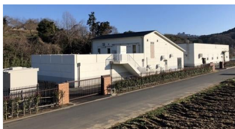
吉沢浄化センターと資源循環施設
