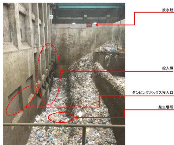
環境事業センターごみピット(見学者コースから)
