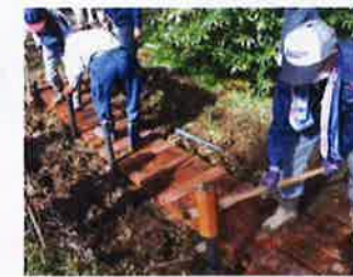
3月整備作業(木道設置)
