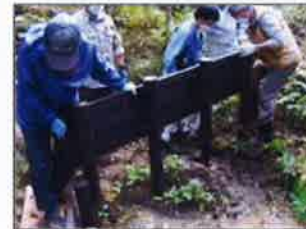
10月実施の土留作業
