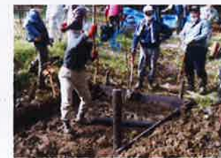
3月整備作業(土留設置)
