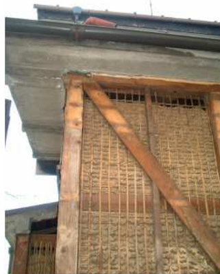
釘打ち(金物なし) F_w=1.9\text{kN/m}
