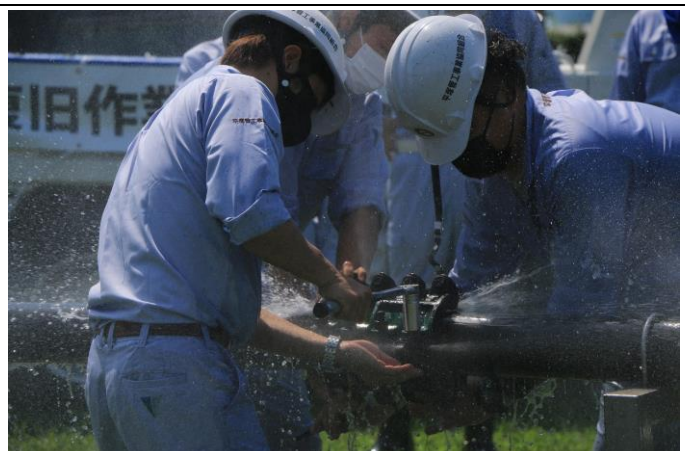
水道管復旧訓練
