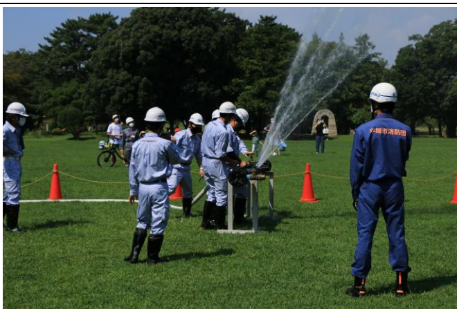
水道管復旧訓練
