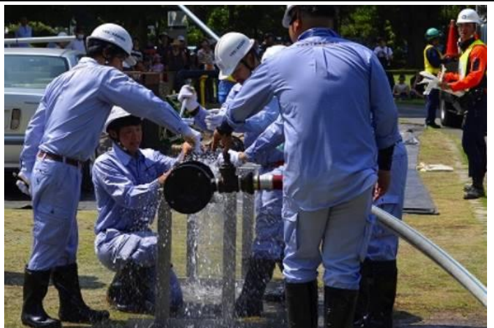
水道管復旧訓練
