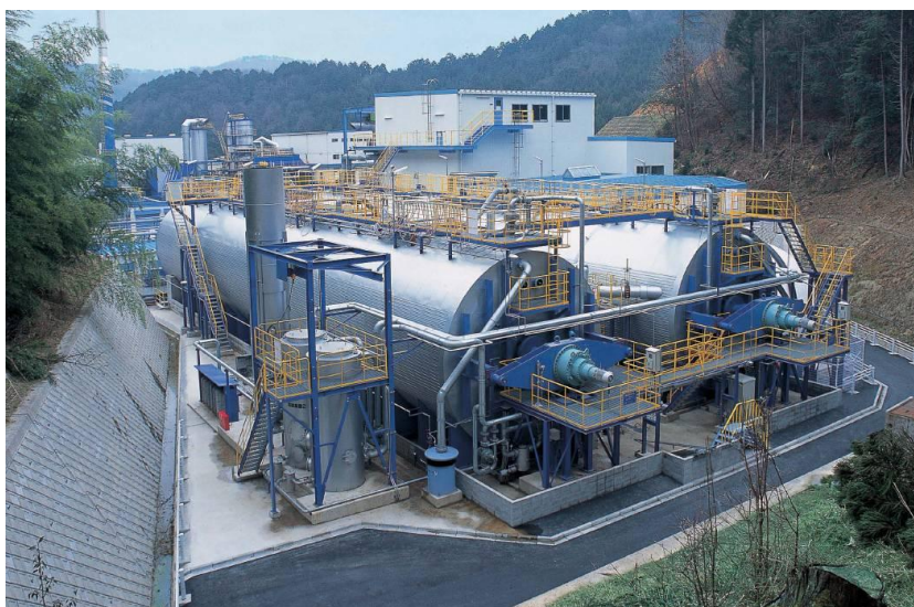
乾式メタン発酵設備（横型；カンポリサイクルプラザ）
