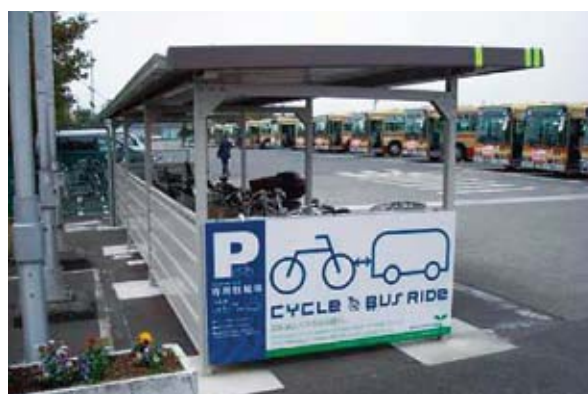
田村車庫バス停の自転車等駐車場 (神奈川中央交通㈱の整備)
