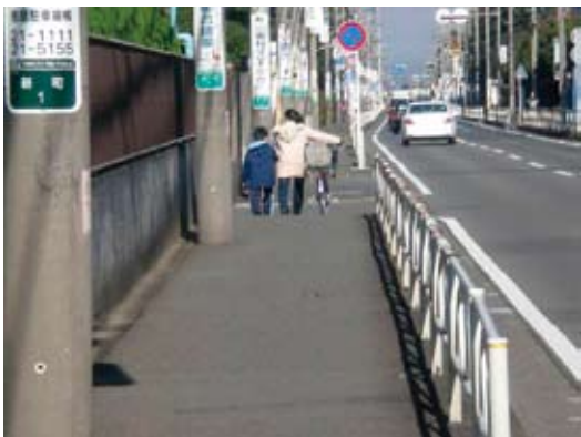
東浅間大島線の平塚市総合公園以北の現状 歩道幅員 2.5 mの内、有効幅員は 1.5 m
