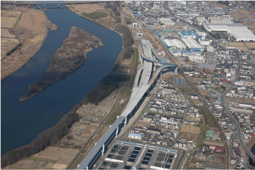
<圏央道（さがみ縦貫道路）寒川北インターチェンジ付近の空中写真>
