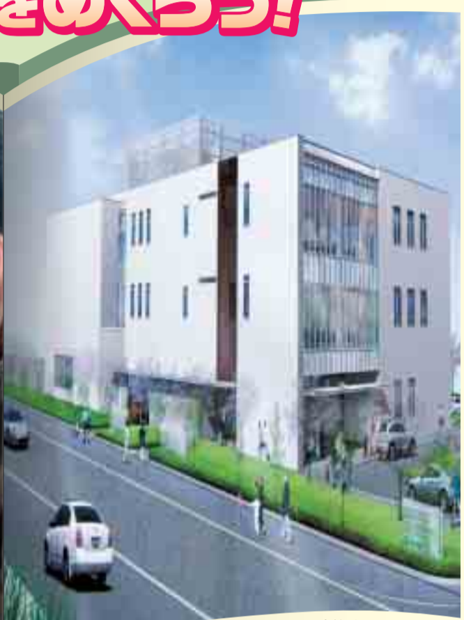
平成20年4月、東豊田にオープンする新保健センター
