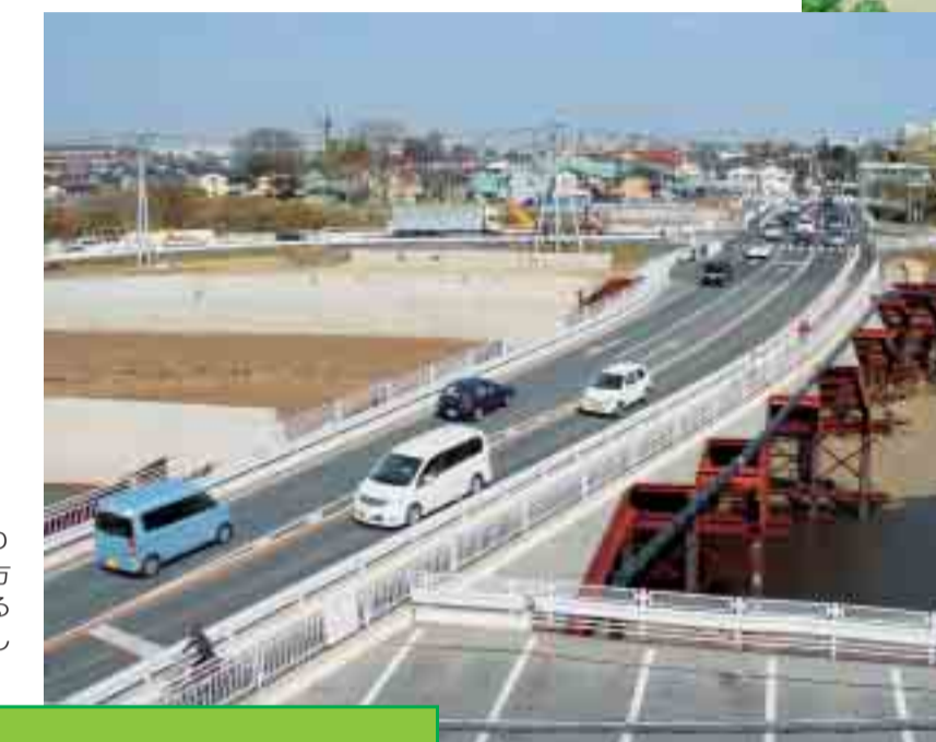
▲平成20年3月にオープンする桜ヶ丘公園の完成イメージ。 ▲平成21年3月の開通に向けて工事が進む東雲橋(写真手前)と玉川橋(写真奥)。現在通行している仮設橋の上流側(写真左側)に新しい橋脚ができています。
