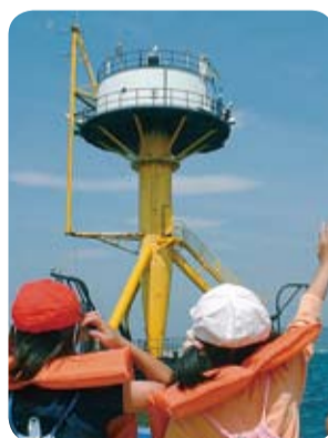
水深20mの海底に立つ波浪等観測塔。海に浮かんでいるではありません。
