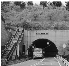
日向岡トンネル
