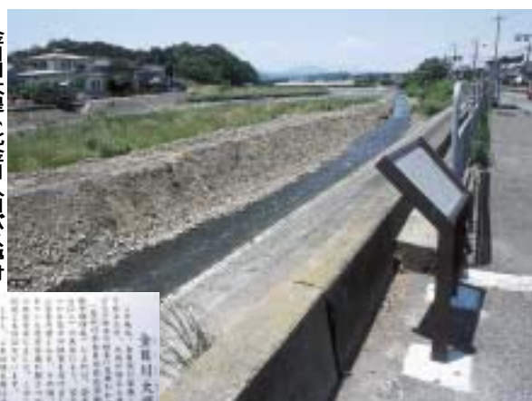
t 今年の3月に設置した金目川大堤の説明板
