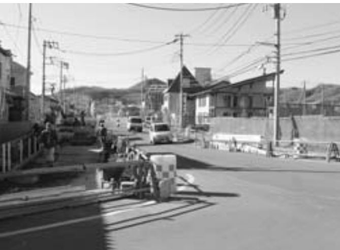
整備が進む事業地内の道路
