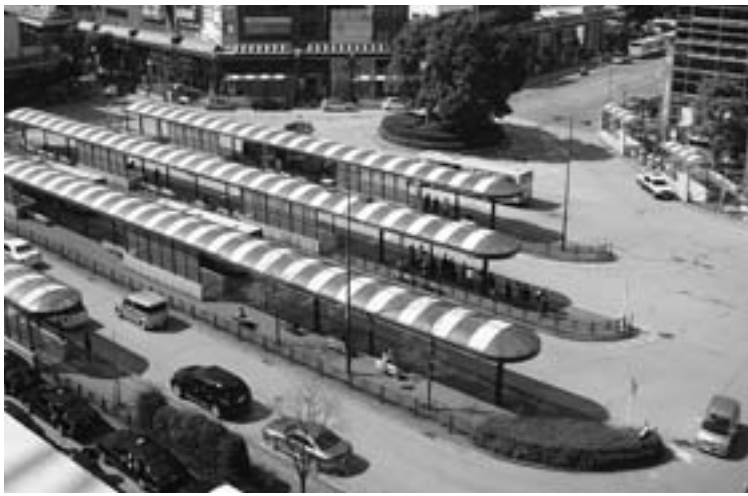
間もなく改修が始まる平塚駅北口駅前広場
