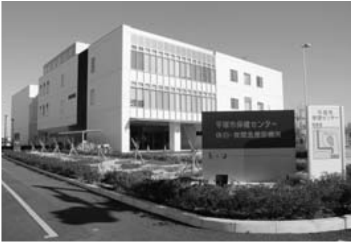
19年度に完成した保健センター
