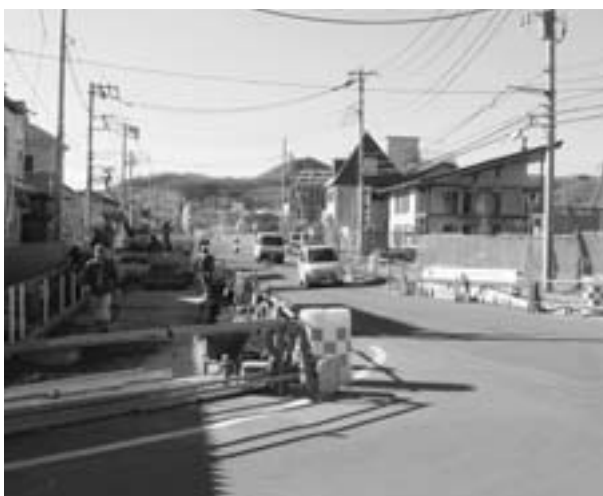
整備が進む事業地内の道路
