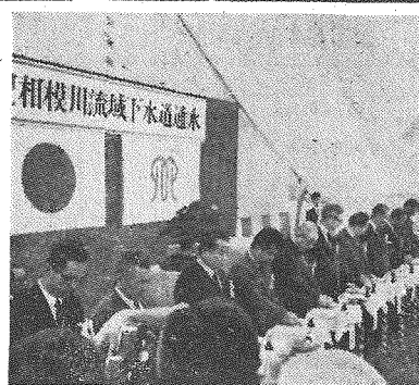
相模川流域下水道の、四之宮に建設中の終末処理場が一部完成。六月二十六日、津田県知事ら流域十二市町長が出席して、通水式が行なわれた。 下水管裏通の水 洗便所の汚水が の広大な処理場で 浄化され、相模川 に放流される。
