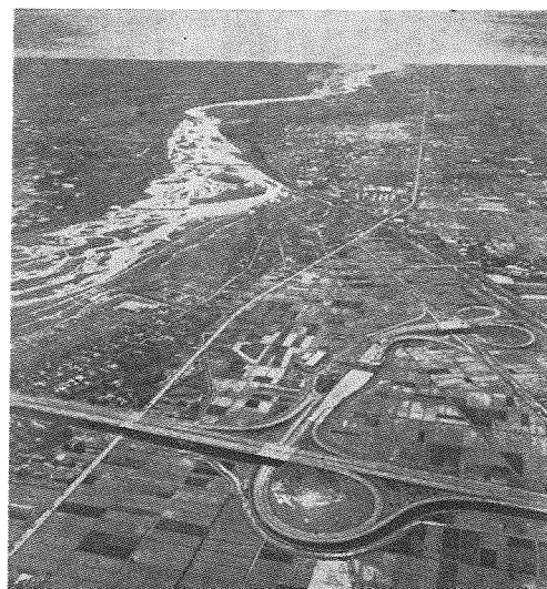
完成した東名厚木インターチェンジ…相模川沿う白い直線が129号線（神奈川新聞社提供）
