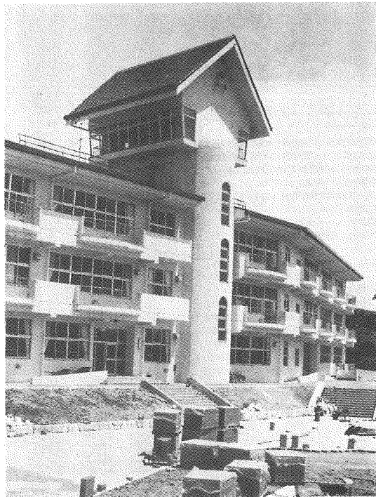
完成した吉沢小学校。屋上には展望台付きの塔屋がある。前庭は整備中
