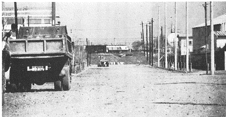
市内第2番目の立体交差地下道がほられる新設の八幡須賀線…中央地下道より大きな規模で42年度までに完成させる予定だ。
