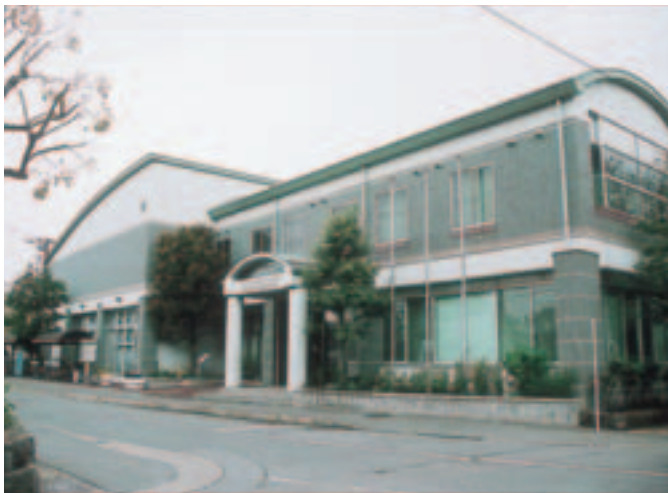
風水害時の避難施設に指定された公民館
