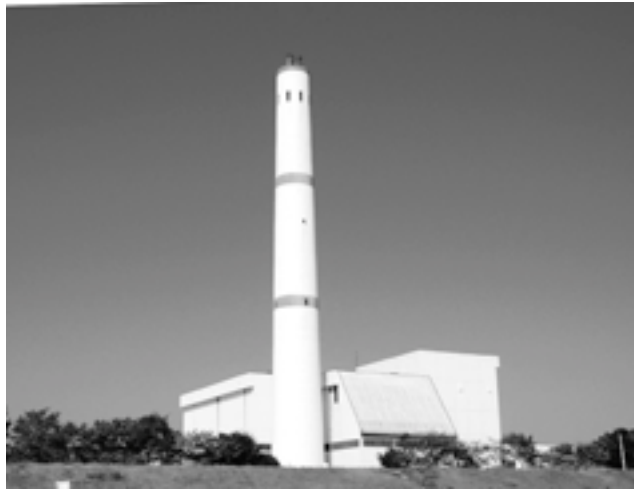
老朽化の進む環境事業センター
