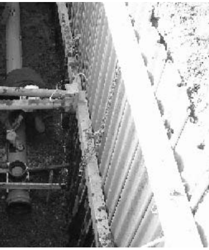
下水道管の布設工事(入野)
