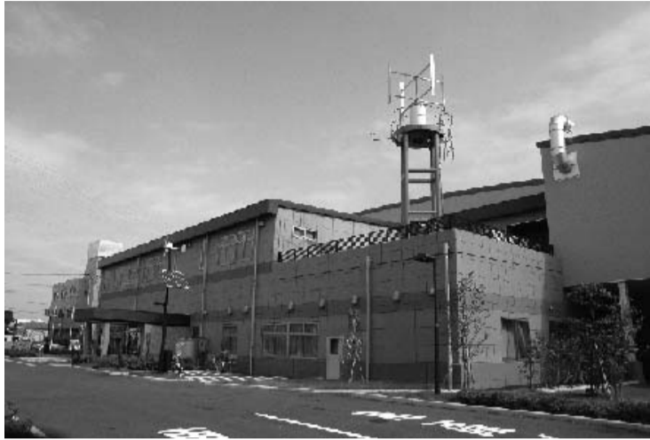
平成15年度に完成したリサイクルプラザ
