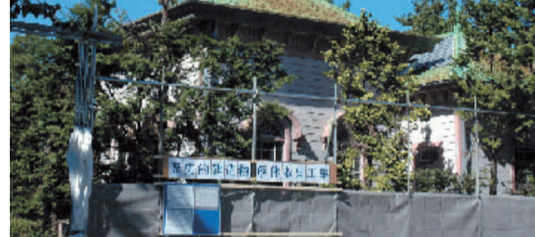
解体収集工事が始まった記念館
