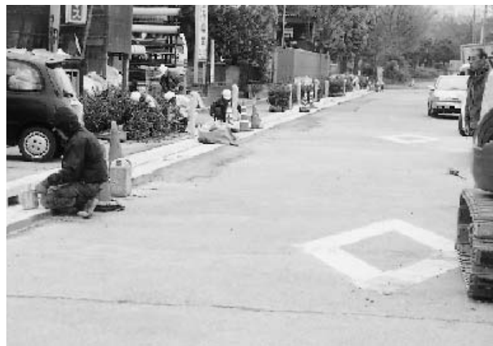
市道中堂16号線の改良工事
