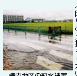
横内地区の冠水被害
