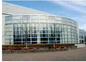
溺死事故が起きた平塚総合体育館プール
