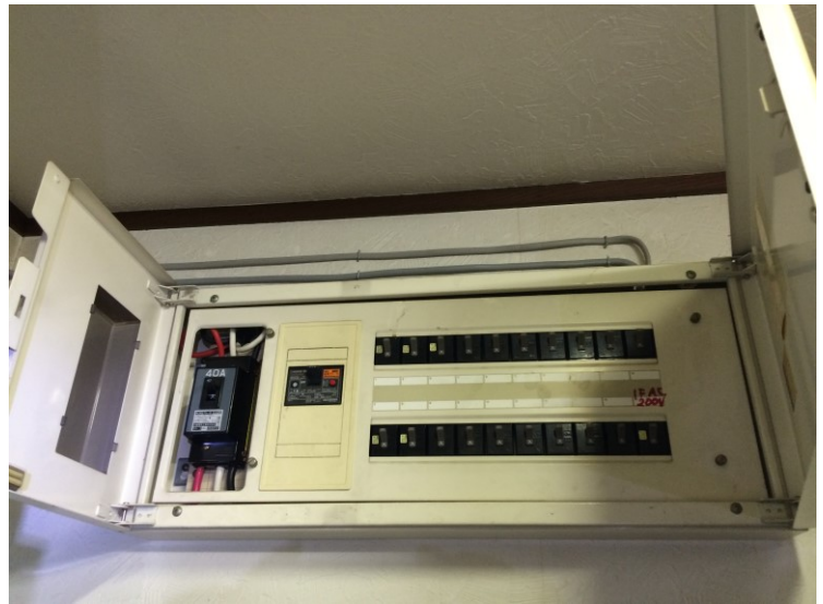
例)⑥金属性蓋観音開き分電盤(蓋が閉まらない)
