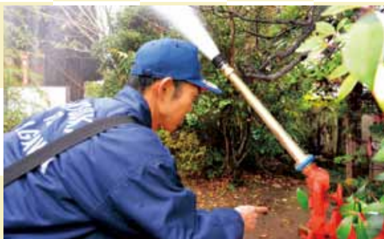
1分間に約600リットルの放水をし、本堂を火災から守る放水銃
