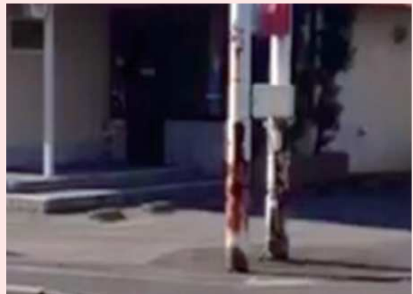
ポールの根腐れ（実際に倒れた看板）
