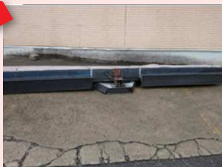
落下した欄間看板
