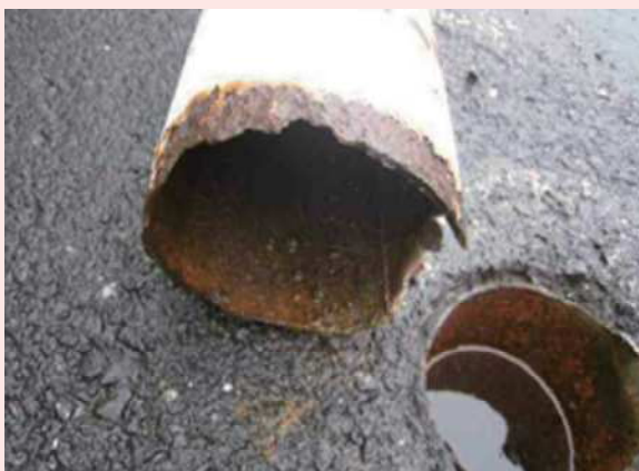
ポールの根腐れによる倒壊
