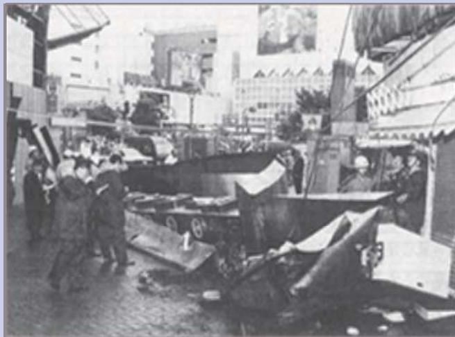
台風で落下した時の様子
