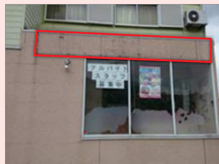
落下した後の壁面
