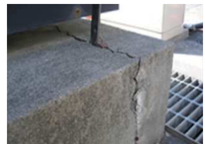
看板基礎のひび割れ
