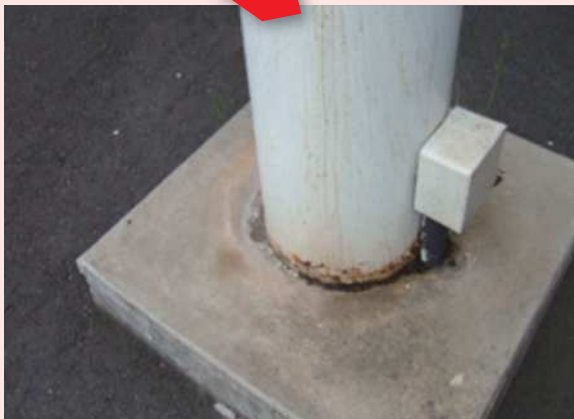
ポールの根元にサビが発生
