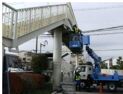
写真5 1 横断歩道橋点検状況
