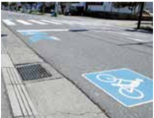
整備が進む自転車通行帯
