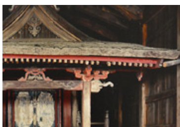
屋根の破損状況
