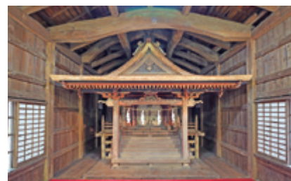
修理後の北金目神社本殿
