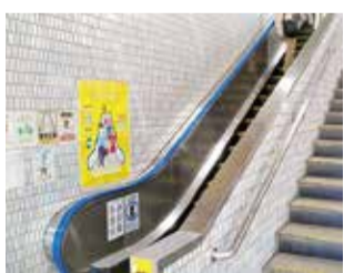
現在の上りエスカレーター
