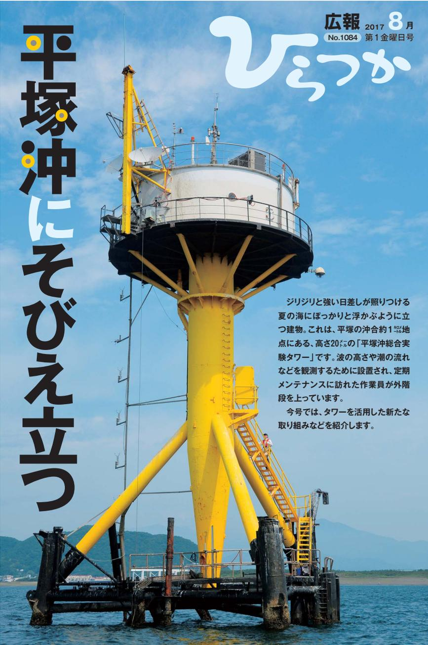
ジリジリと強い日差しが照りつける夏の海にぼっかりと浮かぶように立つ建物。これは、平塚の沖合約1<sup>km</sup>地点にある、高さ20<sup>m</sup>の「平塚沖総合実験タワー」です。波の高さや潮の流れなどを観測するために設置され、定期メンテナンスに訪れた作業員が外階段を上っています。
