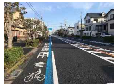
自転車専用通行帯（レーン）
