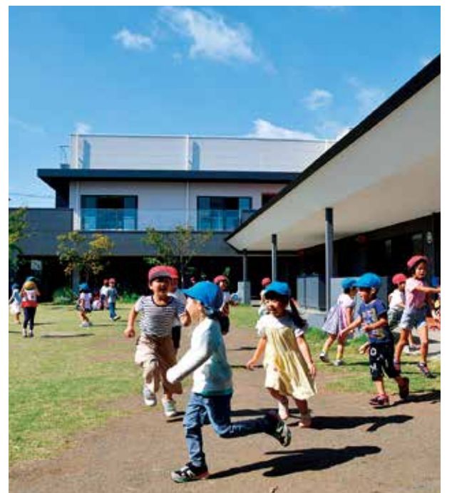
公立保育園の再編で民営化された花水さくら保育園の園舎が令和元年10月に完成しました
