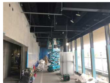
2階ホワイエ黒塗り天井施工状況
