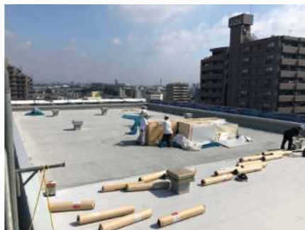
ホール屋上シート防水施工状況
