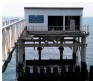
平塚波力発電所
