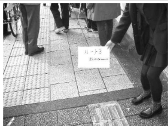
誘導ブロックの不連続
