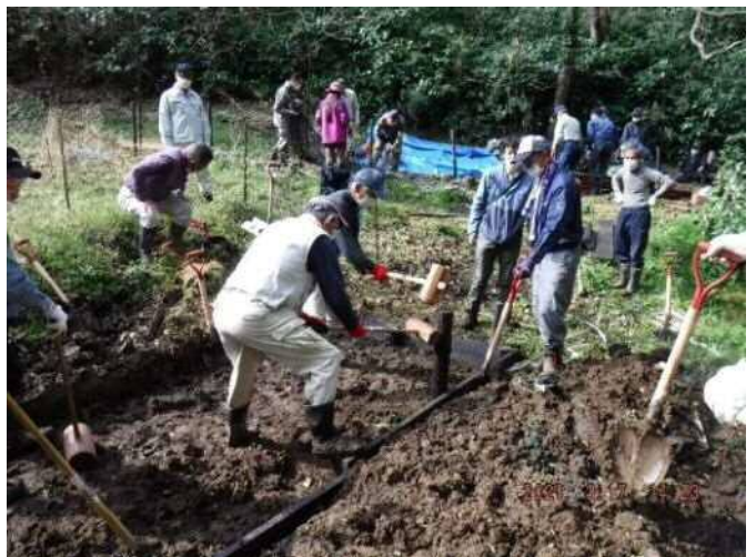
土留めの設置
