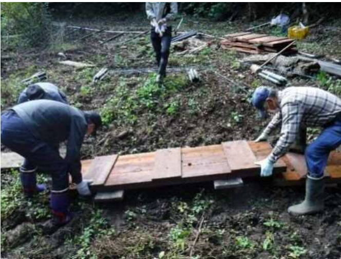
木道用板材の設置
