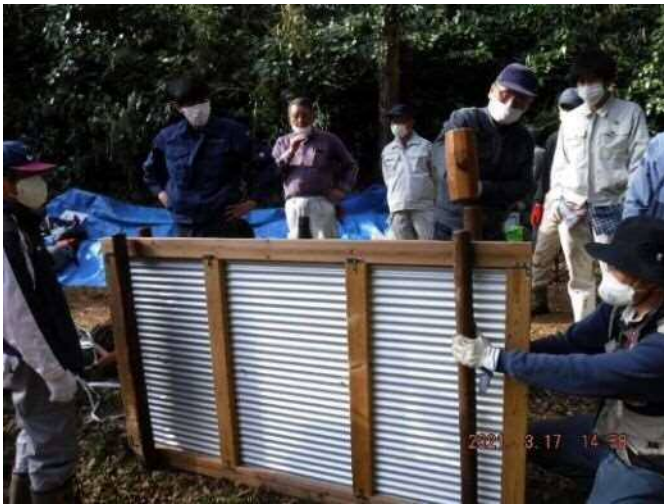
獣害対策用門扉の設置
