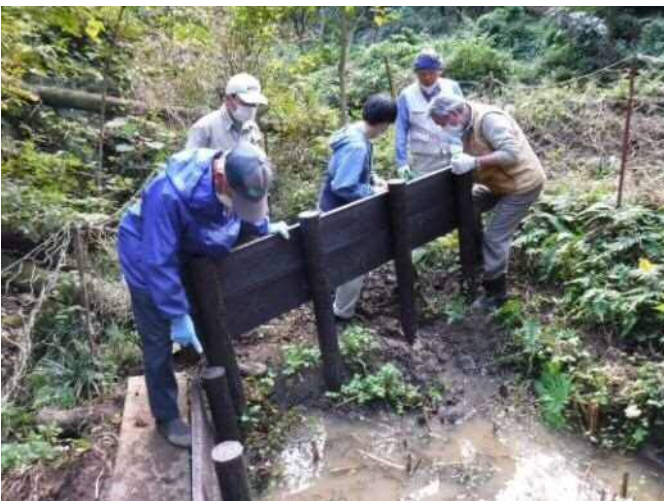
擬木土留めと板材の設置
