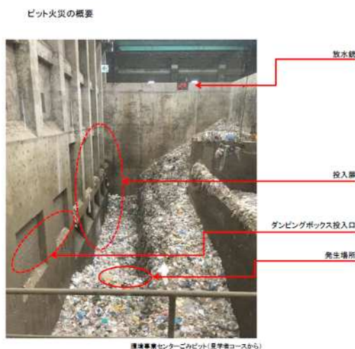
環境事業センターごみピット（見学コースから）
