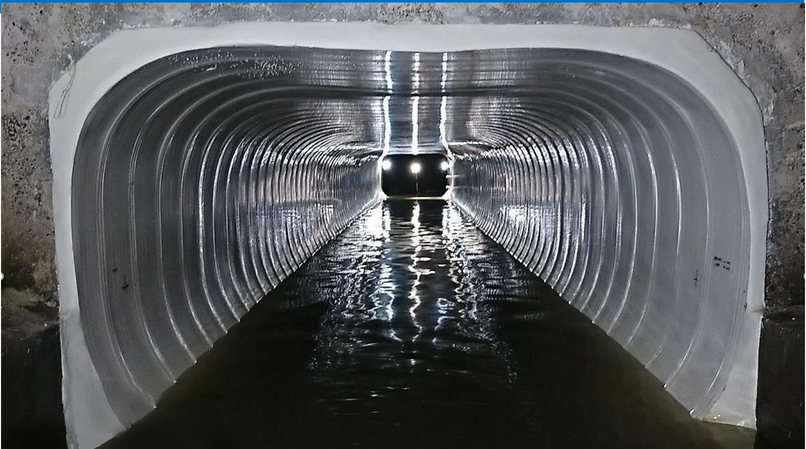
写真：老朽した下水道管の内側に新たな管を入れる「更生工法」で修復した下水道管
