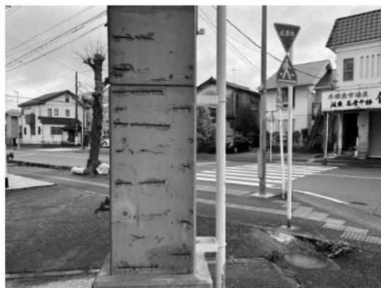
鉄筋が露出した柱
