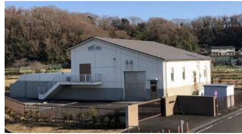
土屋浄化センター
