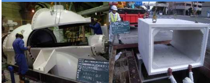
【改築更新】 東部ポンプ場改修工事と国道1号における耐震化工事
