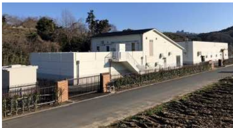
吉沢浄化センターと資源循環施設
