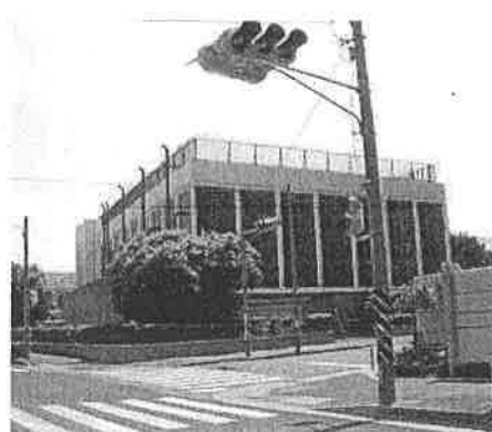
長寿命化対策が必要な東部ポンプ場
