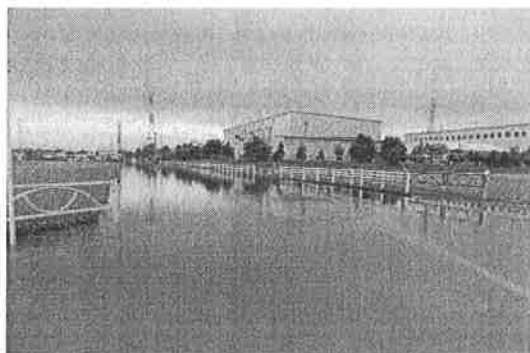
幹道 真土金目線の道路冠水状況
