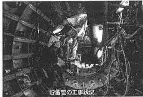
貯留管の工事状況
