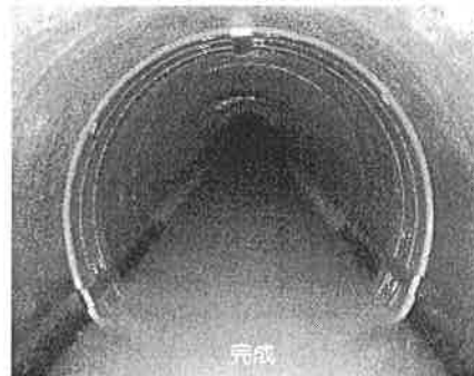
耐震化工事（可とう継手）の整備実績（総合地震対策工事その2）
